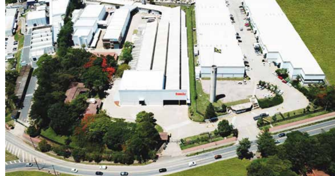
Fábrica da HidroAll, em Valinhos, interior Paulista
